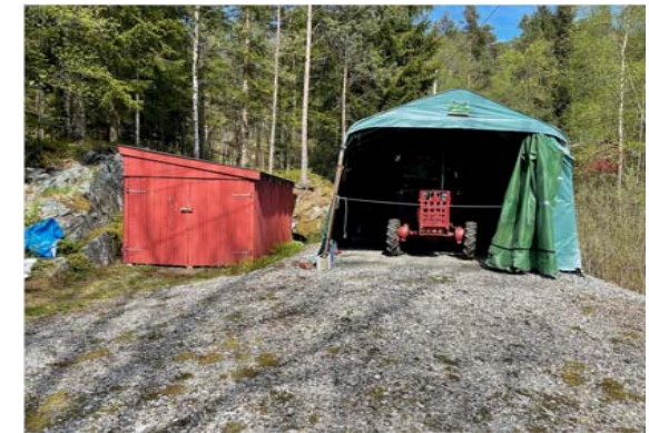
Eksisterende mellombels plasthall og garasje på 13 m2 BYA som skal rives
