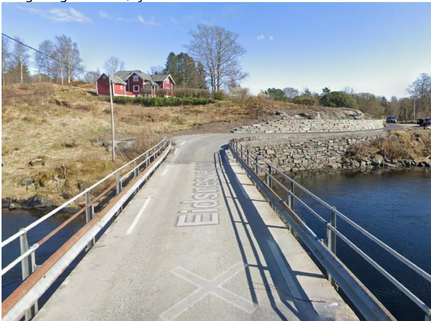
Figur 2 Fv. 5456 på brua, sett mot aust (google.com)
