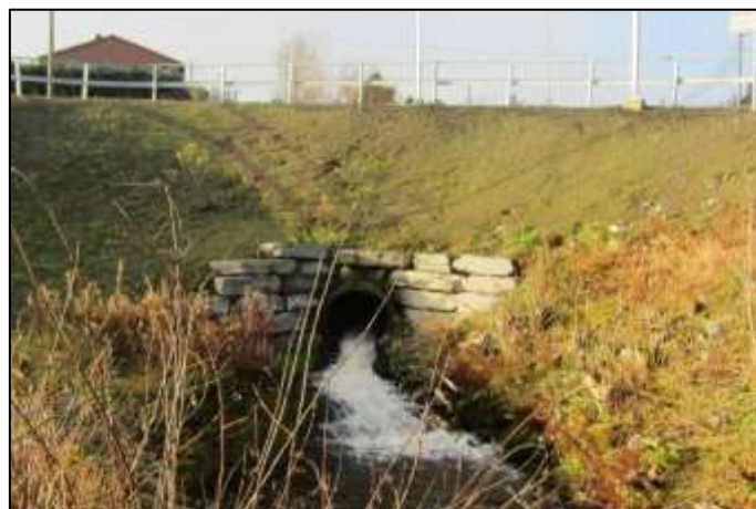
Figur 25: Utløp frå stikkrenna under Ådlandsvegen ved Fossekrysset.
