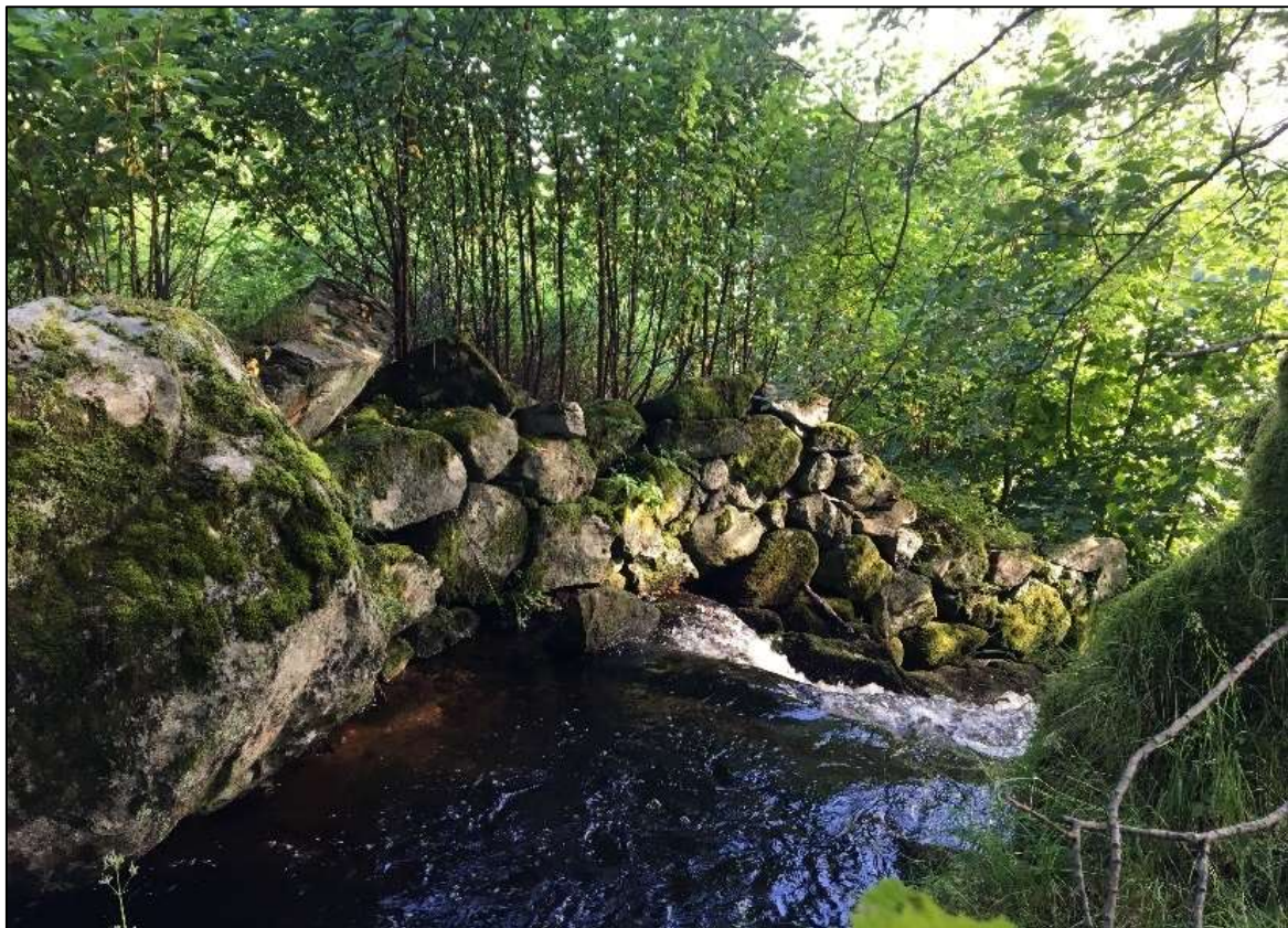
Figur 58: Fossen ned frå kvernhuset er steinsett med ein solid natursteinsmur som er i god stand.
