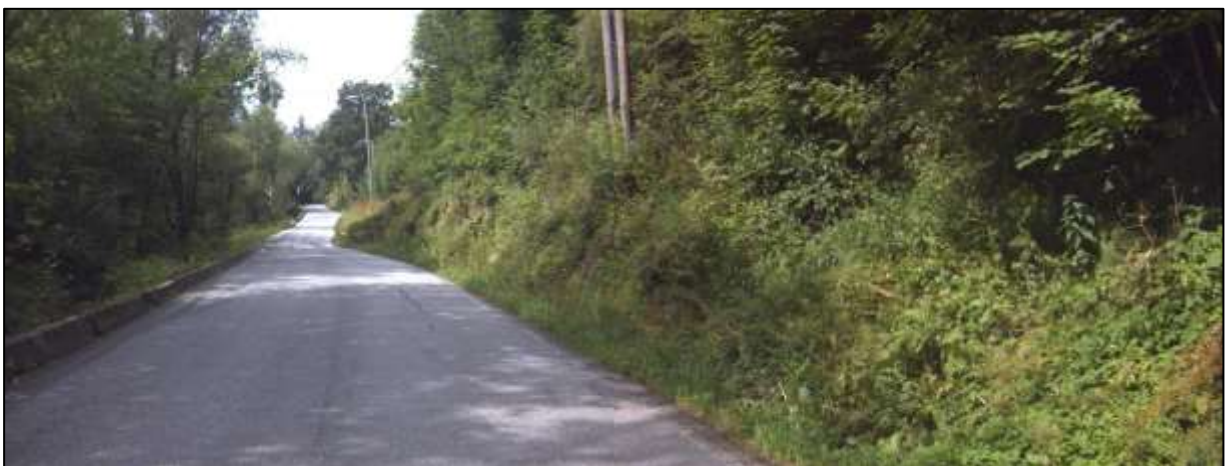
Figur 15: Vegen er fleire stader nede i ei breidde mot 3,5 meter. Foto: SVV
