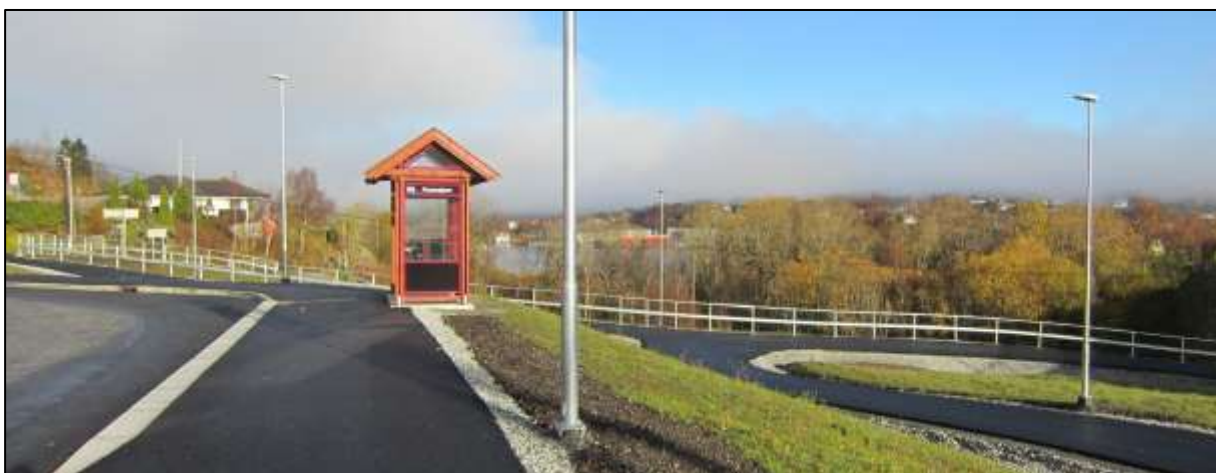
Figur 17: Gang- og sykkeltilbod ved Fossekrysset. Fortau og gangveg til busstopp.
