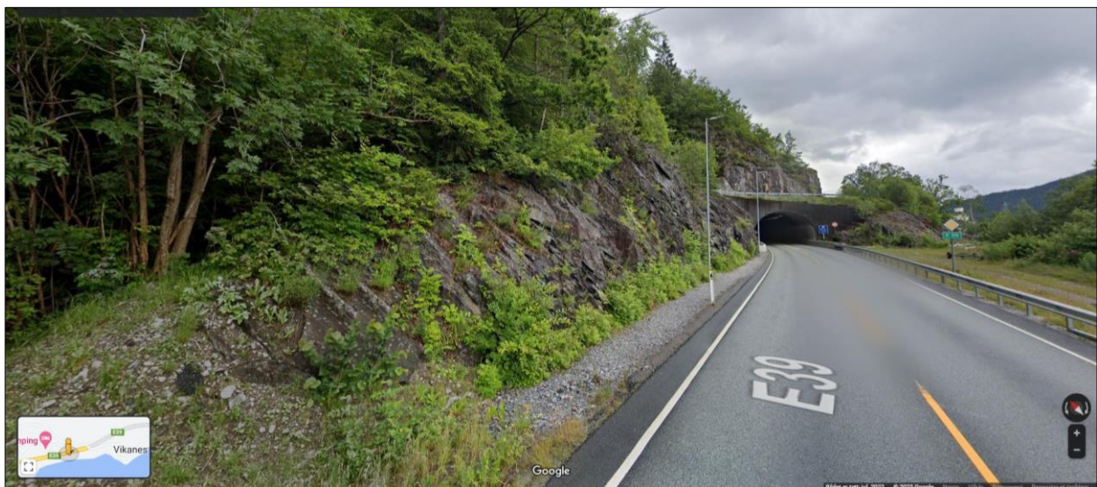
Figur 17: Tunnelskjæring til Vikanestunnelen, sørøst i tiltaksområdet, viser fjell i dagen. Kilde: google.no/maps.
