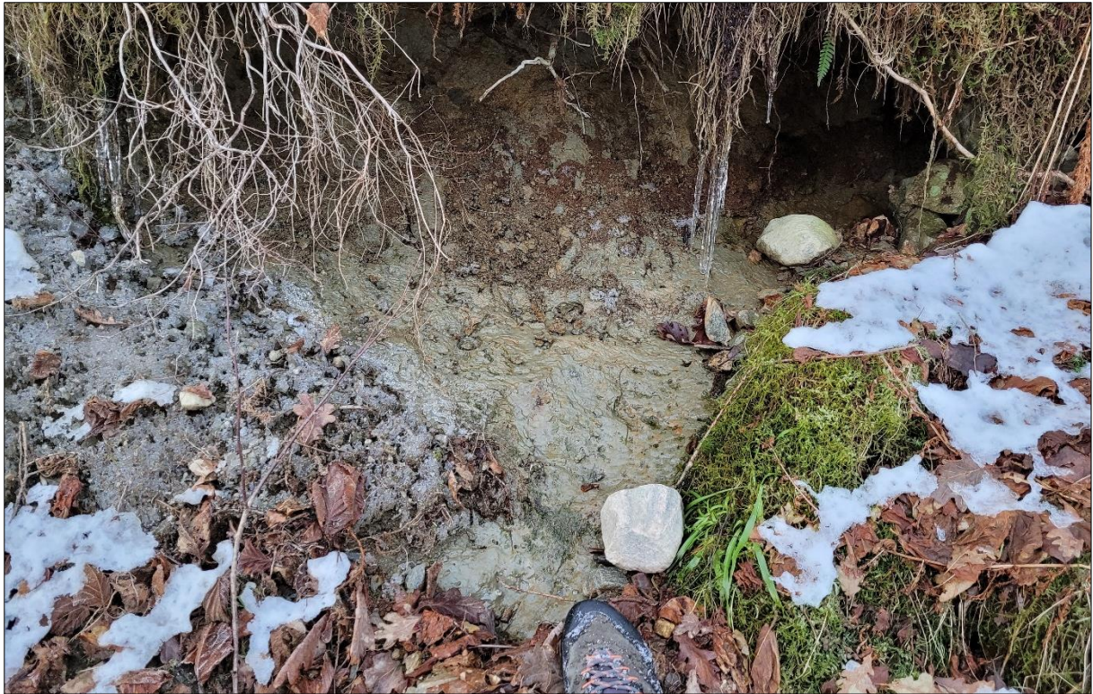
Figur 20: Bildet viser et nærmere utsnitt av skråningen vist i Figur 19. Massene er vurdert som siltig sand (Foto: SGC).
