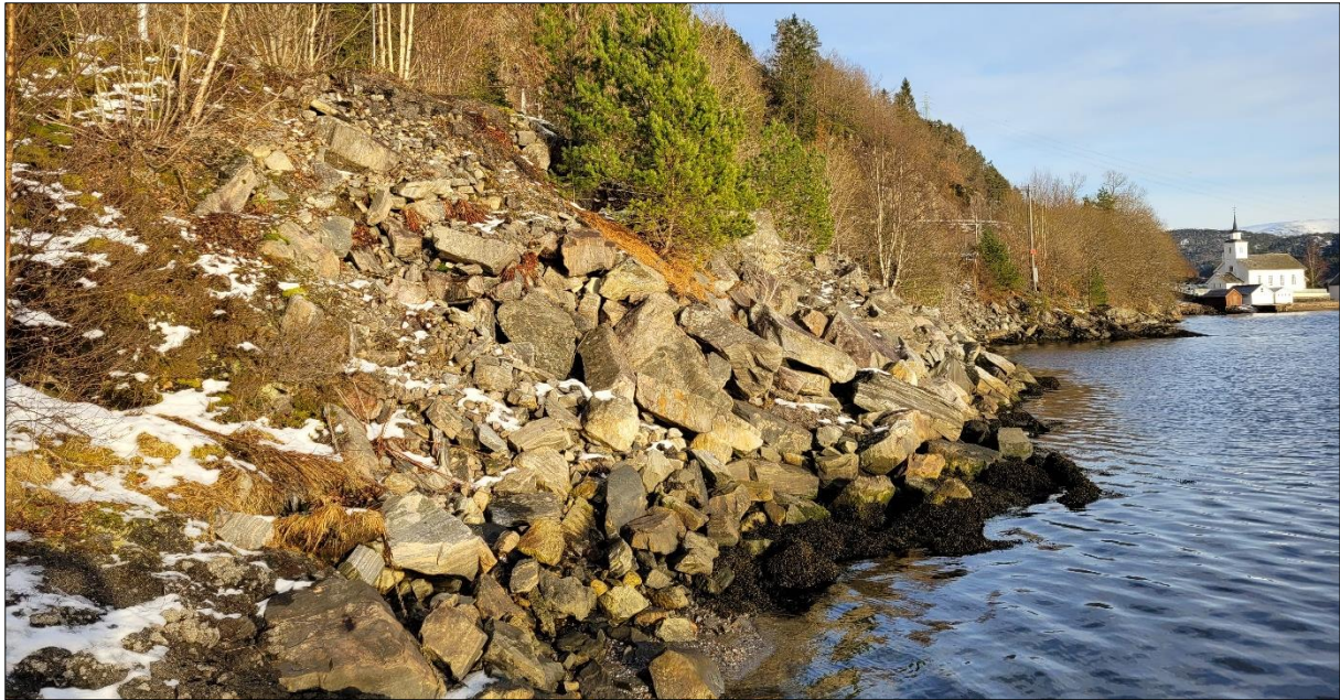
Figur 18: Bildet viser steinfylling i sjø like sør for Osterfjordvegen og Vike Camping. Både vest og øst for steinfyllingen er det langs sjølinjen observert fjell i dagen (Foto: SGC).
