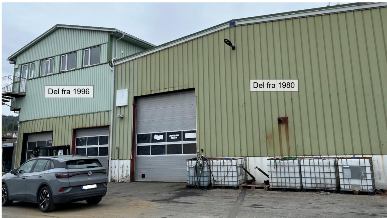
Figur 5: Bilde fra vestvendt fasade Kvassnesvegen 33. Det er malingen på elementene fra delen fra 1980 (mosegrønn farge) som bør prøvetas.
