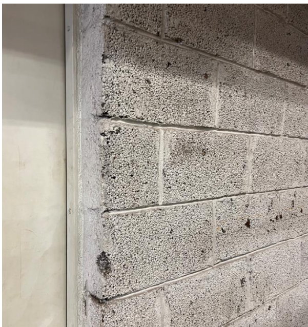
Figur 4: Mulige lecaisoblokker (innvendig vegg, verkstedhall).
