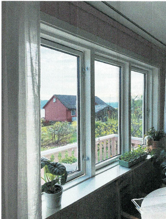
Nye vinduer i stue
