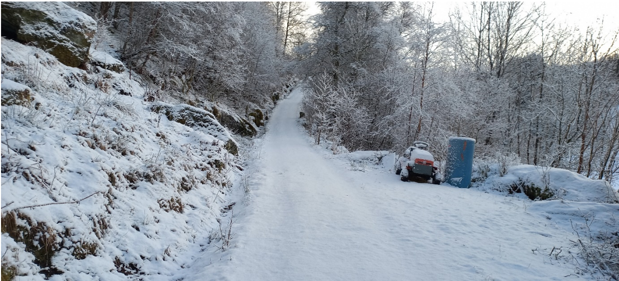
Fig. 1. Særleg i dette partiet (lengst bort frå fotografen) er det uråd å stette krava til stigning for vegklasse 3. Det er ikkje høve til å redusere stigninga i dette området og det er særst bratt ned mot høgre heile vegen opp der vegen er synleg i biletet. Å gå inn i fjellet til høgre, vil gje store skjeringar.
