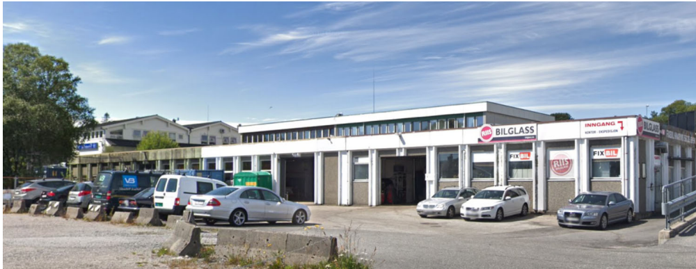
Bruvegen 3, fasade mot sør
