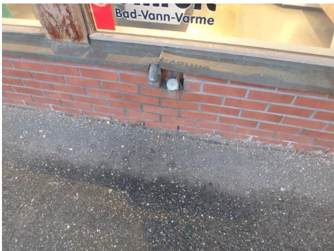
Figur 3 Oljepåfylling på nordsiden av bygget
