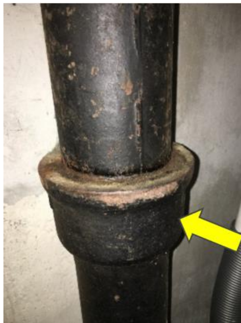
Figur 4 Gammelt avløpsrør av støpejern. Pilen viser plassering av eventuell asbestholdig tettemasse. Det er kun denne typen støpejernsrør vi kjenner til at det kan være brukt asbest i. Det er imidlertid ikke uvanlig at rørene er malt utenpå.
