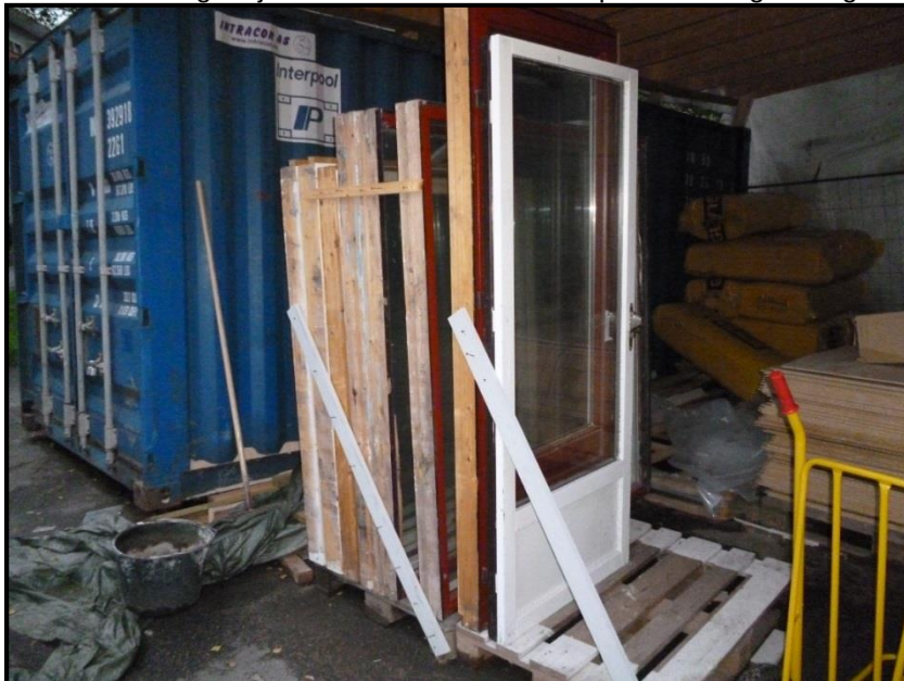
Figur 6: Slik kan vinduer og balkongdører klargjøres for transport.
