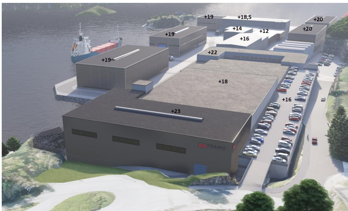
Figur 6-3: Illustrasjon som viser høyder på eksisterende og planlagte bygg i området, vist på perspektiv. Figuren viser gesimshøyde, i kotehøyde meter over havnivå. Kilde: Multiconsult
