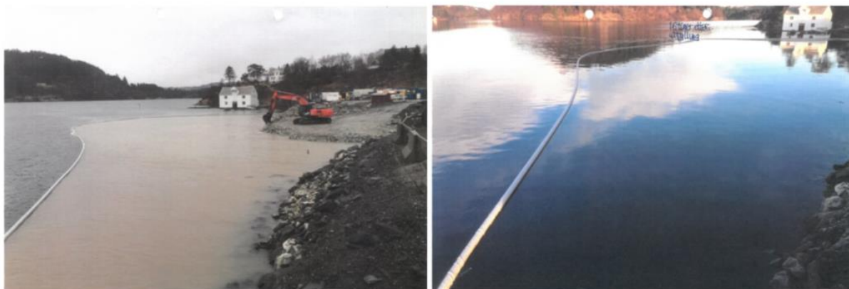
Figur 6-16 Bilde fra utfylling i Kjeldevika og bilde tatt 16 timer etter utfylling. Kilde: Multiconsult
