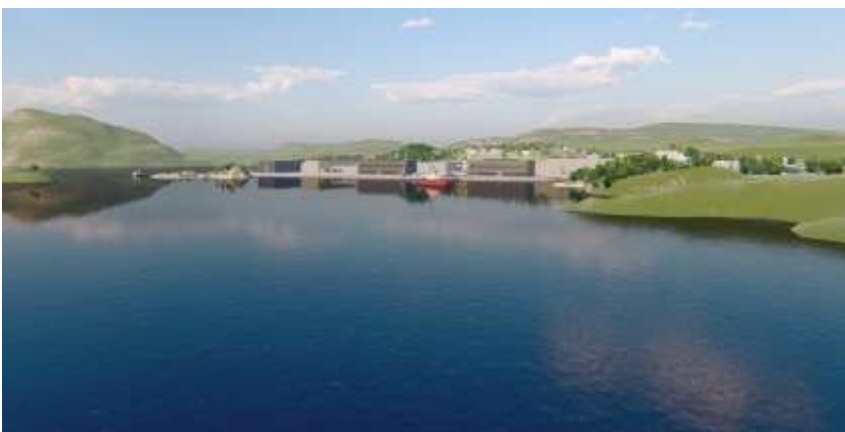
Figur 4-36. Fjernvirkning sett fra Krossnessundbrua. Sammenhengene i landskapet er bevart. III: Multiconsult
