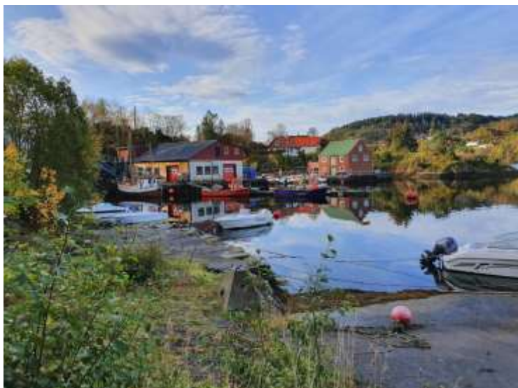
Figur 4-20. Delområdet har en arealbruk preget av båter, kaianlegg, naustbebyggelse knyttet til næring og boliger. Foto: Multiconsult
