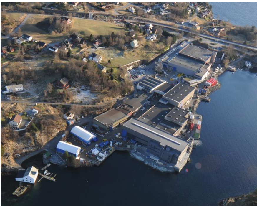
Figur 2-1. Dagens situasjon. Bakenforliggende boligområde og småbåthavn har tilkomst både via næringsområdet og fra nord. Foto: Multiconsult
