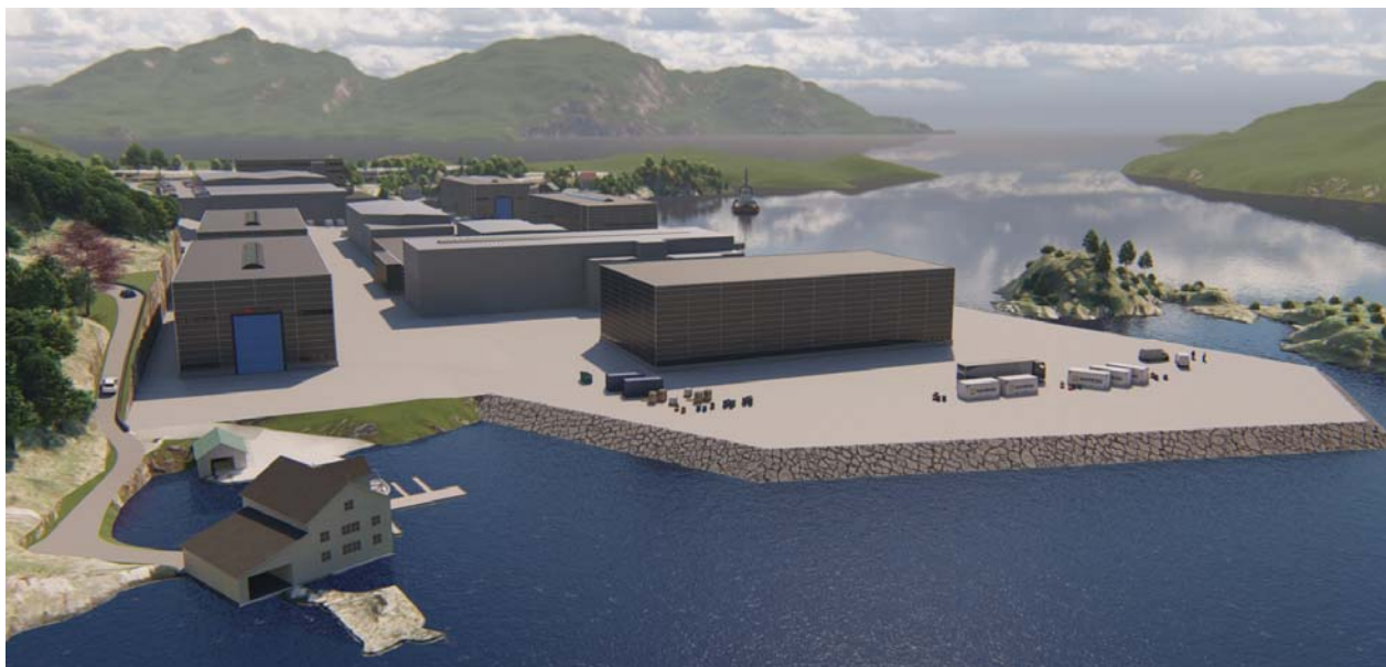
Figur 2-2: Illustrasjonen viser prinsipp for steinsetting av fyllingen. Her vist ved planlagt utfylling mot nord og vest, der Gudmundsholmen ligger til høyre i bildet. Illustrasjon: Multiconsult [1]
