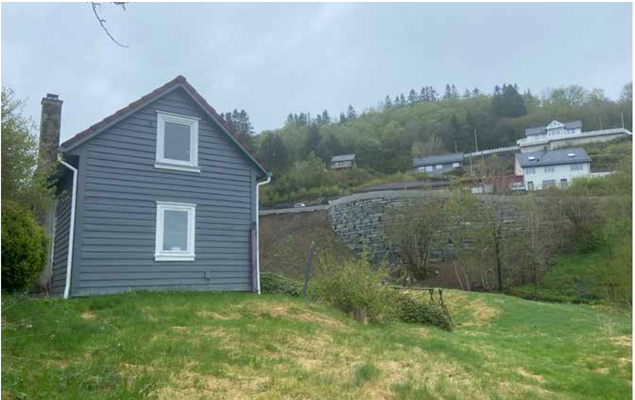
Synfaring – fasade mot sør.
