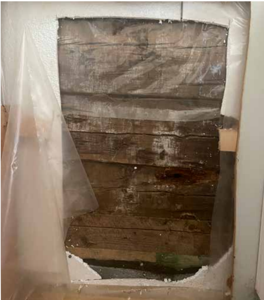
Bildet viser den eldste tømmerkassa mot nord – innvendig fra kjøkkenet. Her ser ein også at botnsvilla er skifta ut og at den i dag ligg på betong.
