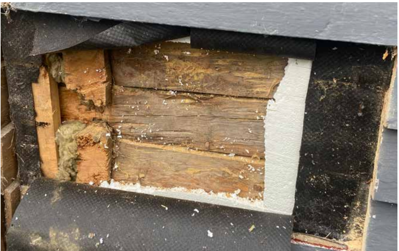
Bildet viser utvendig nordaustre hjørne av den eldste tømmerkassa mot nord.
