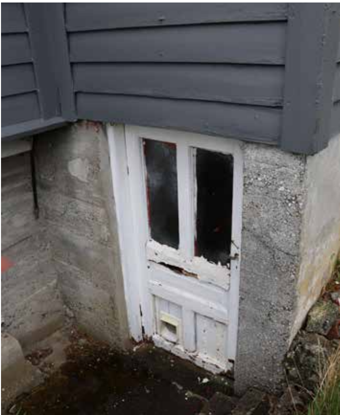
Kjellar, med inngang frå sør.
