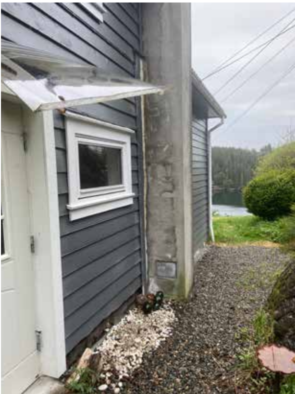
Synfaring – fasade mot vest. Lemstova ligg tett inntil berg på denne sida, så det er vanskeleg å få bilde av heile fasaden.
