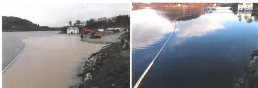
Figur 6-16 Bilde fra utfylling i Kjeldevika og bilde tatt 16 timer etter utfylling. Kilde: Multiconsult
