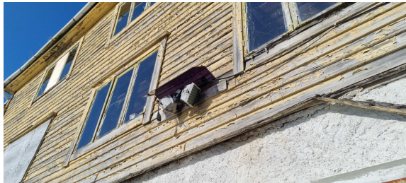
Bilde 10 – Lysarmaturer med lysstoffrør.
