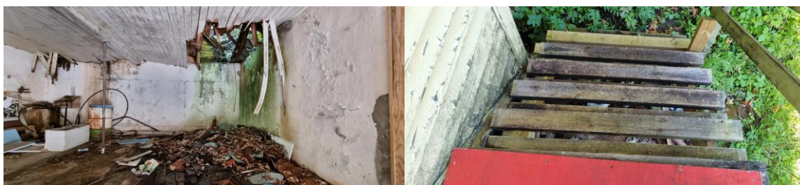
Bilde 7 – Grunnmur / kjellervegger.
