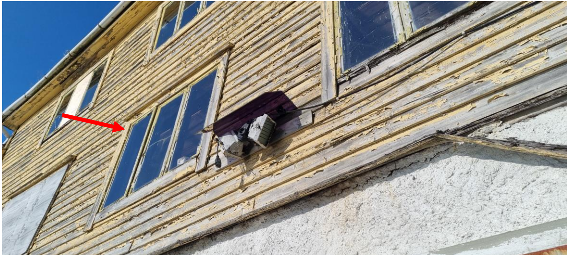
Bilde 2 – Vinduskitt inneholder ikke asbest.
