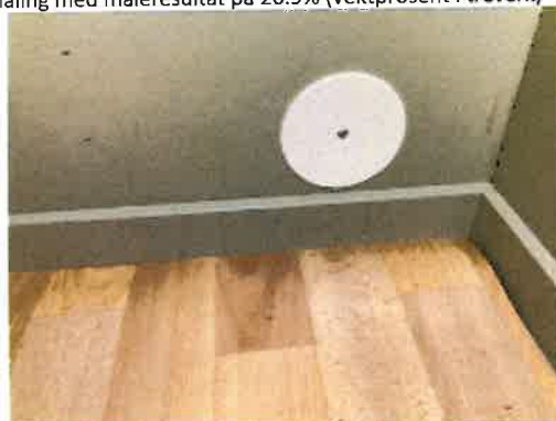
Dekkløkk montert etter hulltaking
