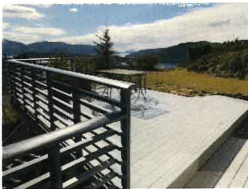
Terrasse ut fra stue
