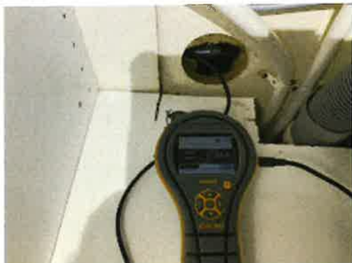
Fuktmåling fra kjøkkenbenk
