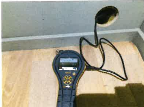
Fuktmåling med måleresultat på 20,9% (vektprosent i treverk)
