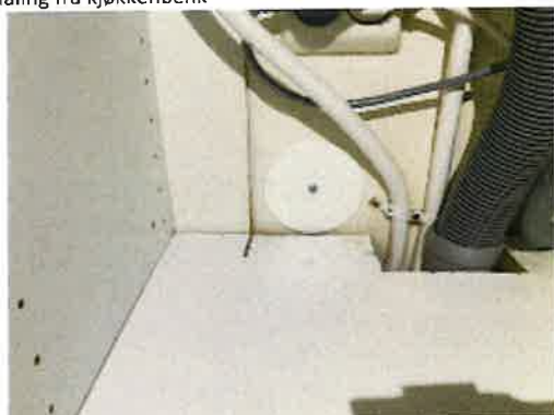
Dekkløkk montert etter hulltaking
