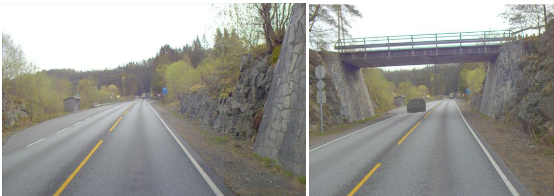
Fylkesvegen 57 med Bussholdeplass og brua over fylkesvegen.
