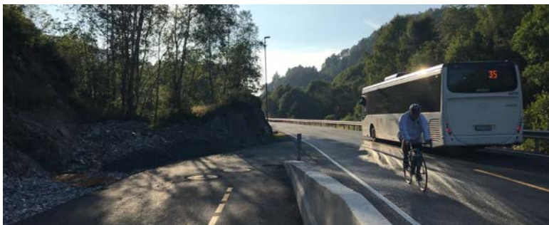
Planlegger: Sykkelveg med fortau, Salhusveien. Foto: Kristoffer Sandvik Monsen
