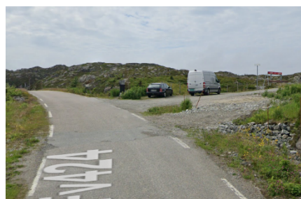
Bilde frå andre retninga som viser at det framstår som at det er to avkøyrslpunkt der det kun skal vere eitt.
