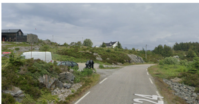
Avkøyrsla vist i Google Street View frå juni 2019. Det kan sjå ut som at postkassestativet står i siktsona.
