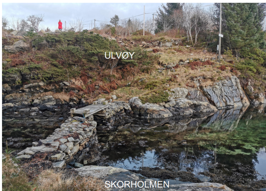
Fig. 1. Steinbrua. Tilkomsten ned til steinbrua frå Ulvøyna må kallast ei «rås» (enkel sti). Kjelde: Ramme-søknad v/ Kvalbein Korsøen Arkitektur AS.
