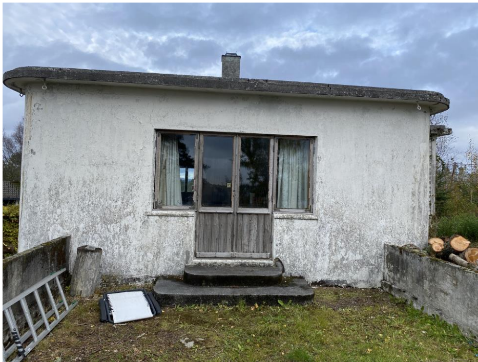
Fig.05 Eksisterende bolig sett mot Nord-øst
