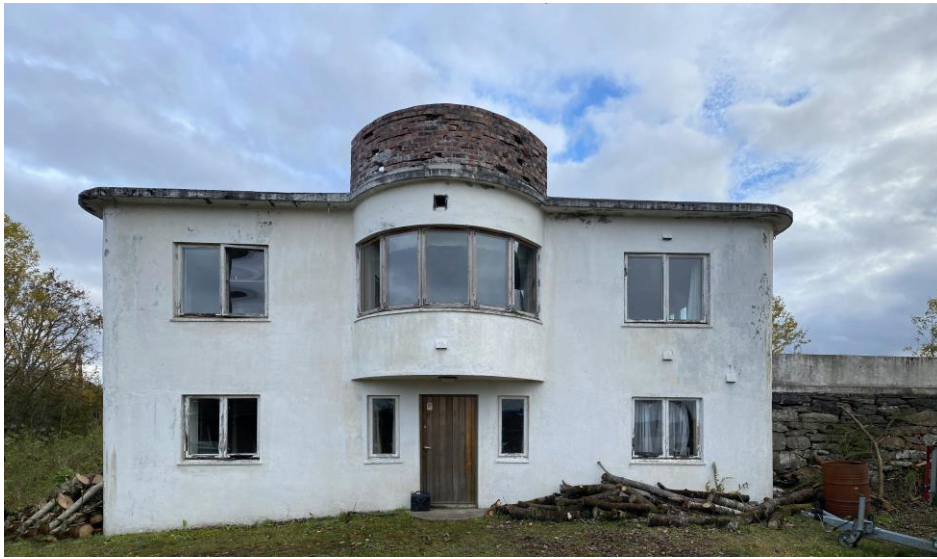
Fig.02 Eksisterende bolig sett mot syd-øst
