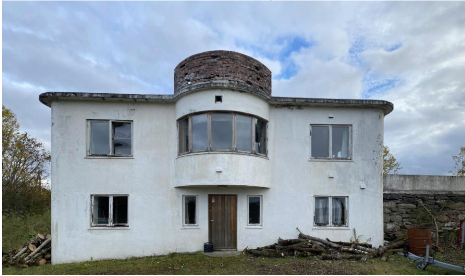
Fig.02 Eksisterende bolig sett mot syd-øst
