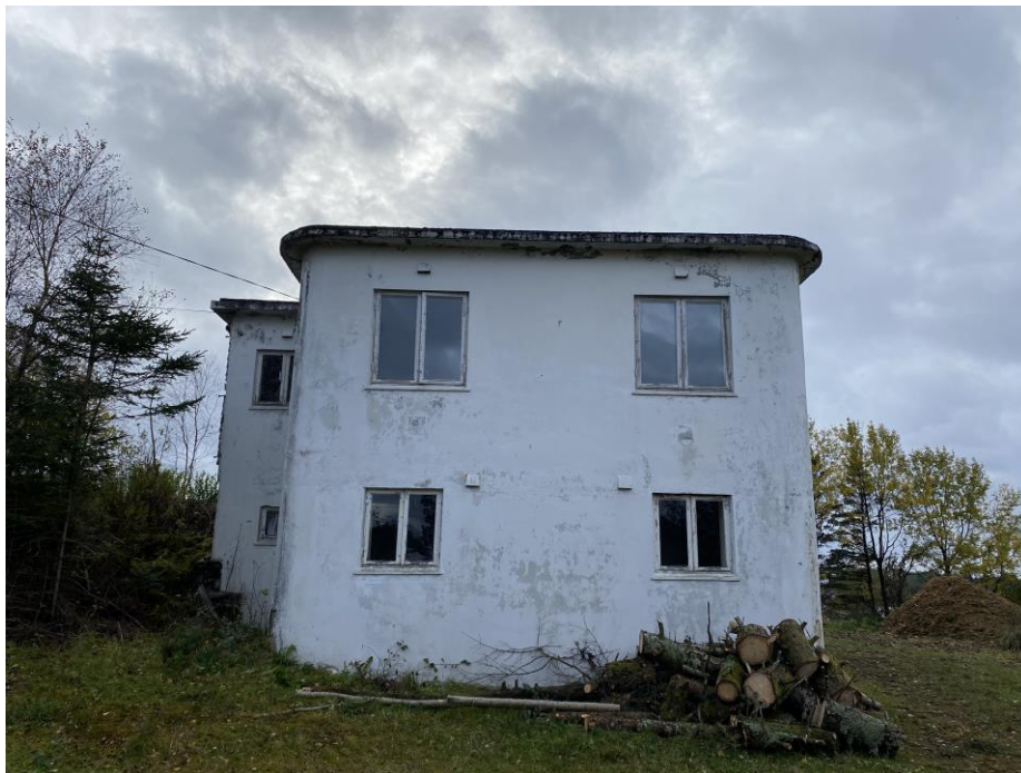
Fig.04 Eksisterende bolig sett mot syd-vest
