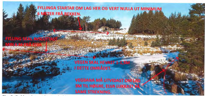
Fig. 2. Bakken lengst borte skal jammast (planerast) ut om lag ned mot der den stripla lina markerer at bakkenivået vert nådd. Sjå òg fig. 4. I tillegg må vegen i framkant utvidast i innersvingen. Dette då den i dag er for krapp slik at det ber utfordrande å kome forbi med større bilar. Elva som vegen kryssar her, må leggast i røy om lag 3 meter utover dagens situasjon dvs frå vegen og om lag til den stripla lina. Vegen må òg hevast om lag 1-1,5 m i denne svingen. Utover dette skal elva framleis liggje open som i dag, men den må reinskast når det er naudsynt. I dette området ligg det ein kommunal vassleiing som det lyt takast omsyn til.
