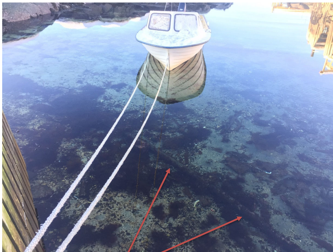
Dagens avløpsledning fra bnr.27. (Grunneiers båt (bnr.3)).
