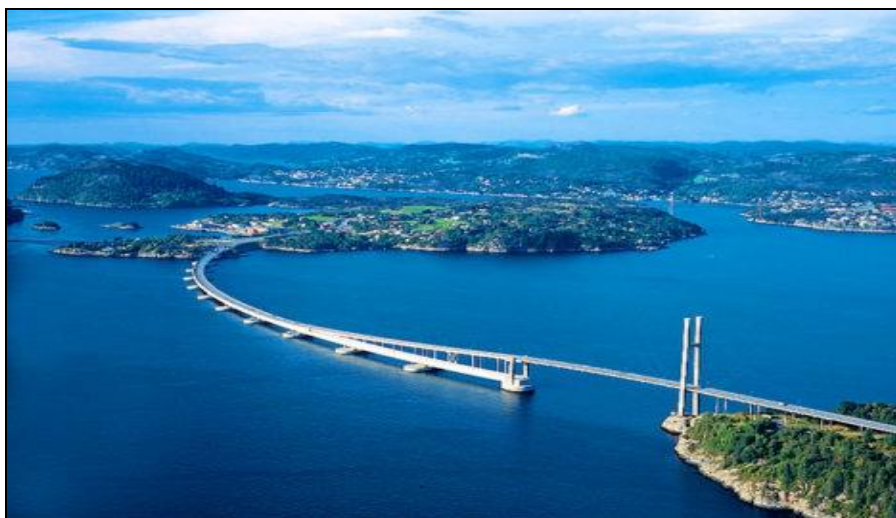
FIGUR 5. NORDHORDLANDSBRUA OPNA I 1994 OG HAR VORE EIT VIKTIG INFRASTRUKTURPROSJEKT FOR UTVIKLINGA I REGIONEN. TRAFIKKEN I OPNINGSÅRET VAR OM LAG 6.000 ÅDT OG ER I DAG AUKA TIL CA. 16.000 ÅDT.
