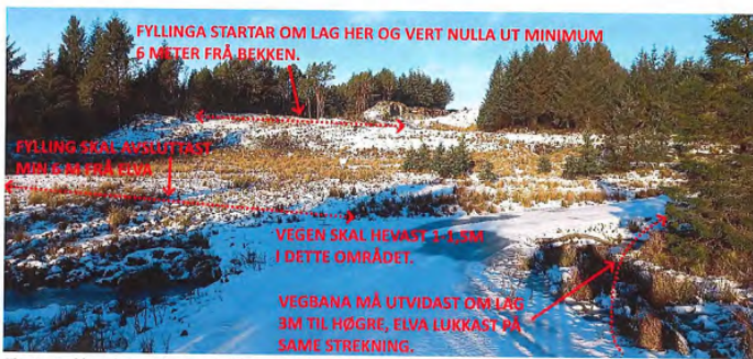
Fig. 2. Bakken lengst borte skal jamnast (planerast) ut om lag ned mot der den stripla lina markerer at bakkenivået vert nådd. Sjå òg fig. 4. I tillegg må vegen i framkant utvidast i innersvingen. Dette då den i dag er for krapp slik at det ber utfordrande å kome forbi med større bilar. Elva som vegen kryssar her, må leggjast i røy om lag 3 meter utover dagens situasjon dvs frå vegen og om lag til den stripla lina. Vegen må òg hevast om lag 1-1,5 m i denne svingen. Utover dette skal elva framleis liggje open som i dag, men den må reinskast når det er naudsynt. I dette området ligg det ein kommunal vassleidning som det lyt takast omsyn til.
