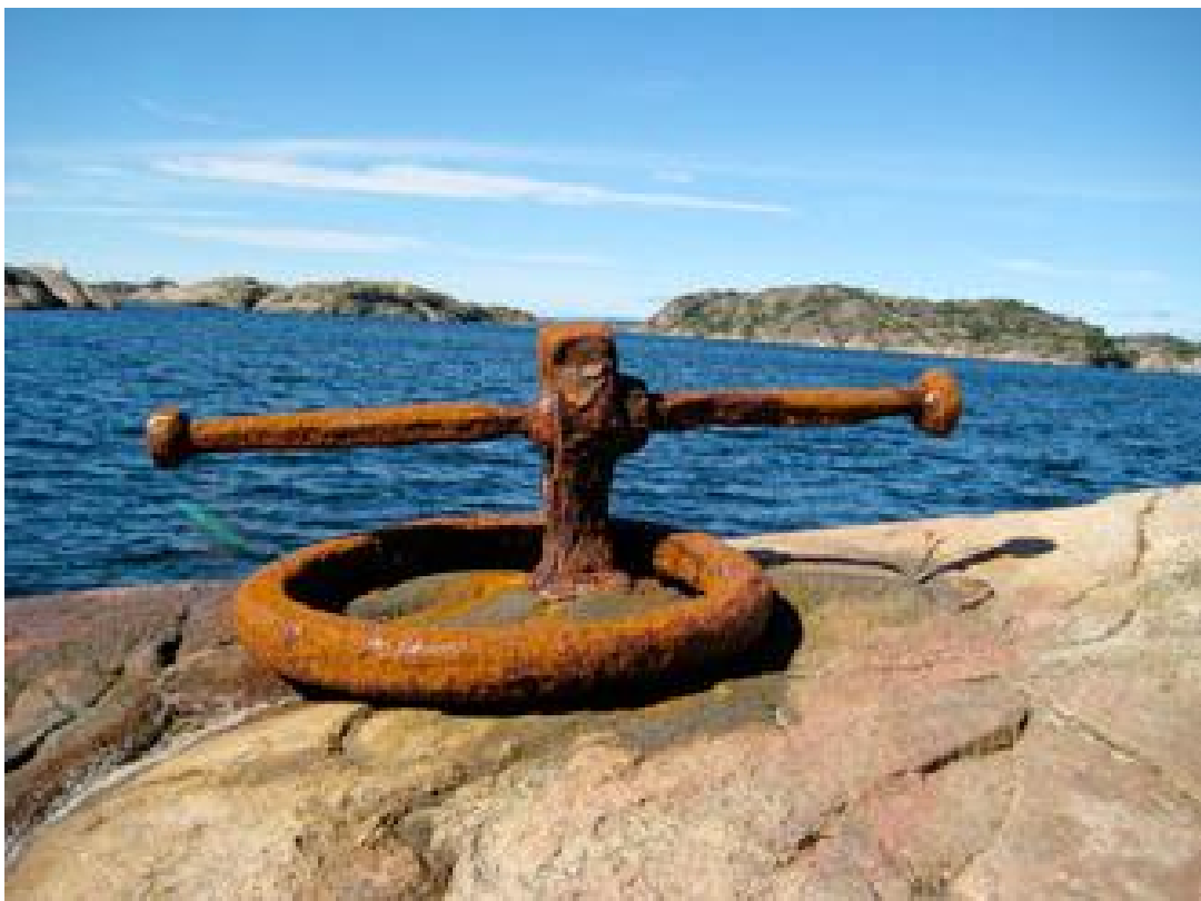
Døme på Kryssbolt med ring
