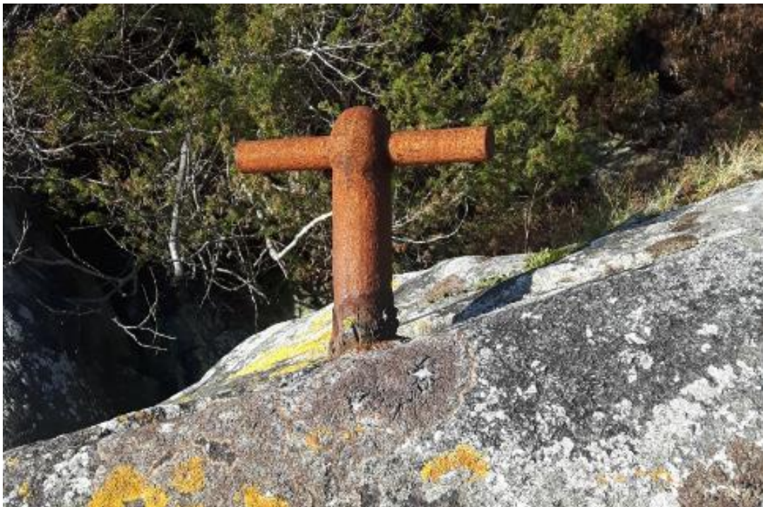
Døme på Kryssbolt uten ring
