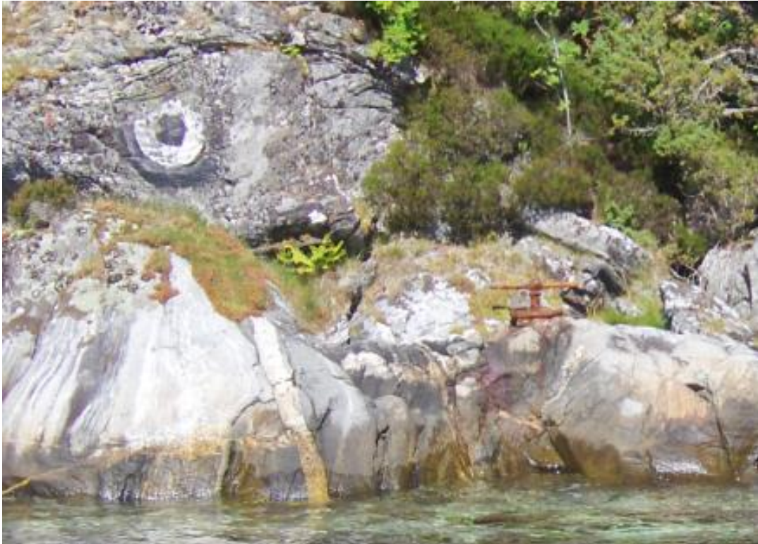
Døme på kryssbolt med ring og ringmerke malt på berget - Foto: Kjell Isaksen
