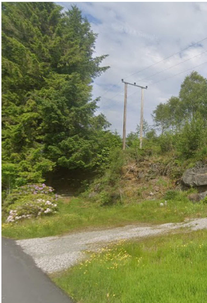
Strømledning går over profil 13, så høyt at det trolig ikke utgjør noen risiko for høye biler.
