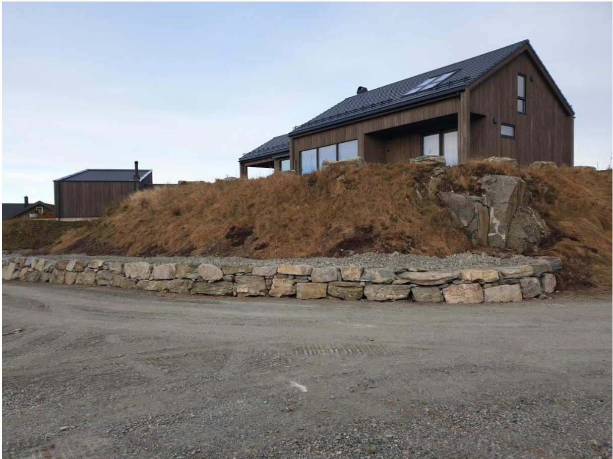
Vedlegg 4_ foto mur
