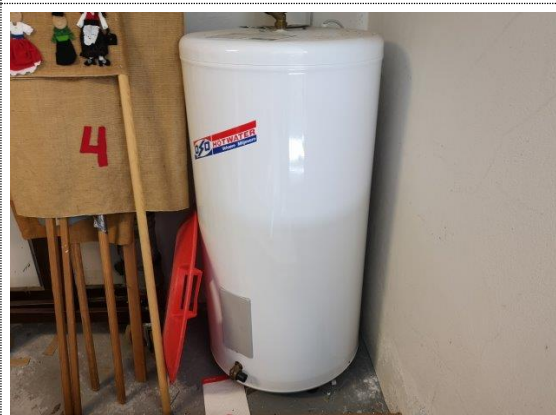
Bilde nr. 310.06 VVB i E-blokken fra 1996. Passert teknisk levetid.
