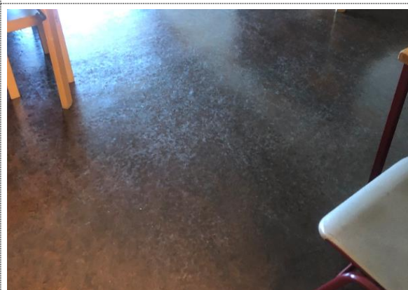
Bilde nr. 255.03 Gulvoverflater Det er registrert slitte gulvbelegg noen steder.
