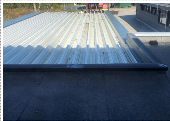
Bilde nr. 260.02 Yttertak Tak med korrugerte stålplater over inngangsparti.
