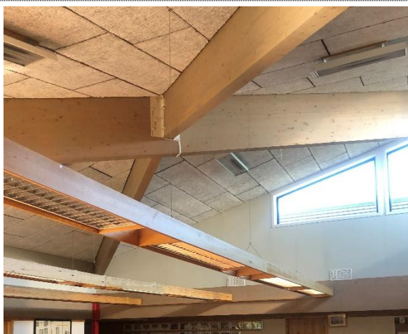
Bilde nr. 220.01 Bæresystemer Limtredragere i generelt god stand.
