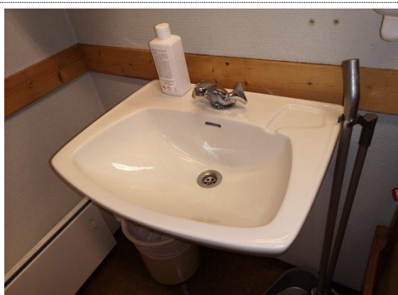
Bilde nr. 310.05 Typisk servant med gammelt togreps blandebatteri
