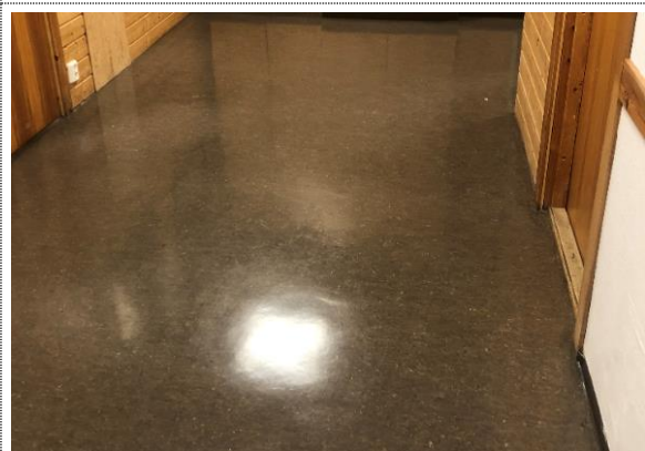
Bilde nr. 255.01 Gulvoverflater Gulvbelegg i generelt god stand.
