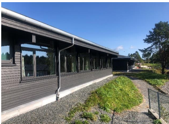
Bilde nr. 230.01 Yttervegger Liggende kledning fra 2016.
