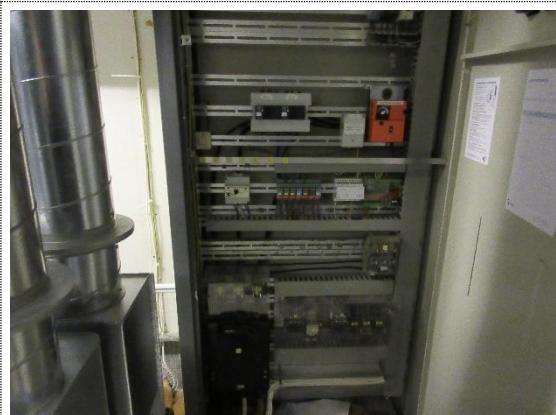
430.05 Eldre ventilasjonsstyring
