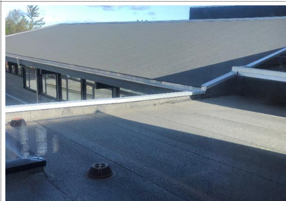
Bilde nr. 260.01 Yttertak Yttertak rehabilitert i 2016.
