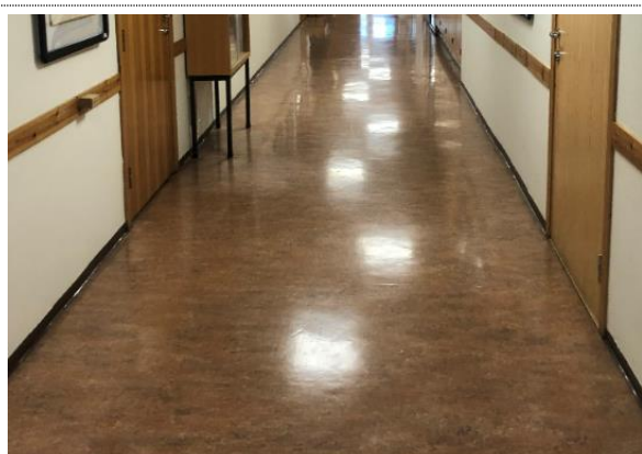
Bilde nr. 255.02 Gulvoverflater Gulvbelegg i generelt god stand.
