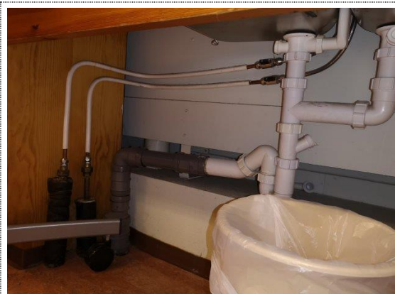
Bilde nr. 310.02 KV og VV rør hovedsakelig i kobber
