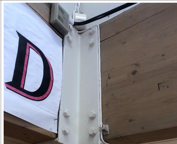
Bilde nr. 220.02 Bæresystemer Stålsøyler og forbindelser i god stand.
