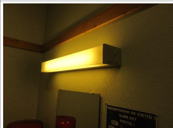
440.04 Speilarmatur med lysrør
