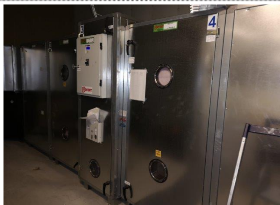
Bilde nr. 360.02 Coventaggregat fra 2015. Det er ett slik i hver av blokkene A, B, C og D.
