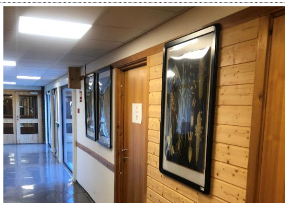
Bilde nr. 240.01 Innervegger Panel og gips i generelt god stand.
