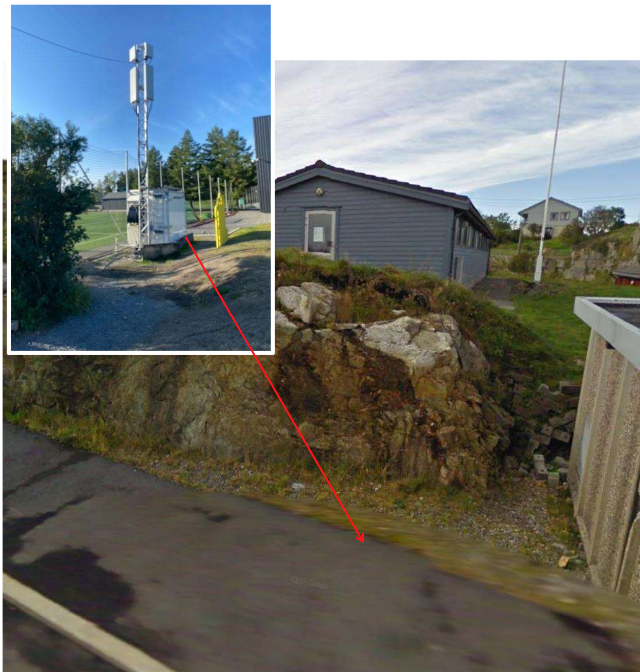
Bilde 6-7: Viser planlagt plassering av mobilvogn med antenne / mast og utstyr. Lite bilde viser eksempel på mobil vogn.
