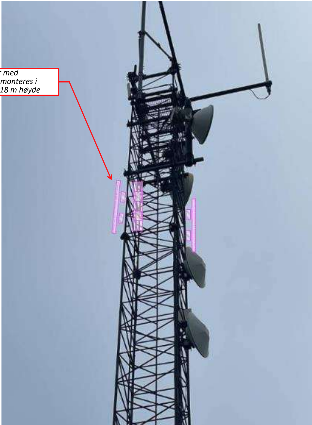
Bilde 4: Viser masten med illustrasjon av planlagt antenner og radiomoduler
