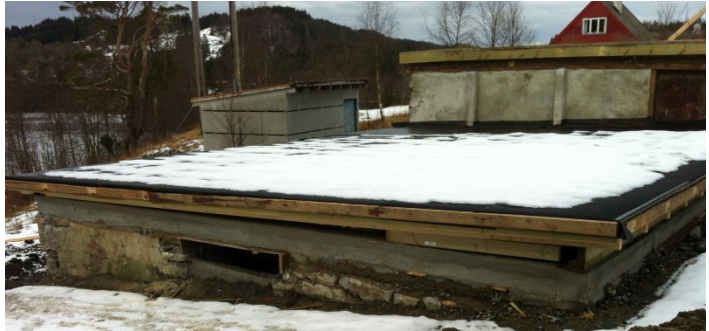
Foto etter brannen med nye tak:
