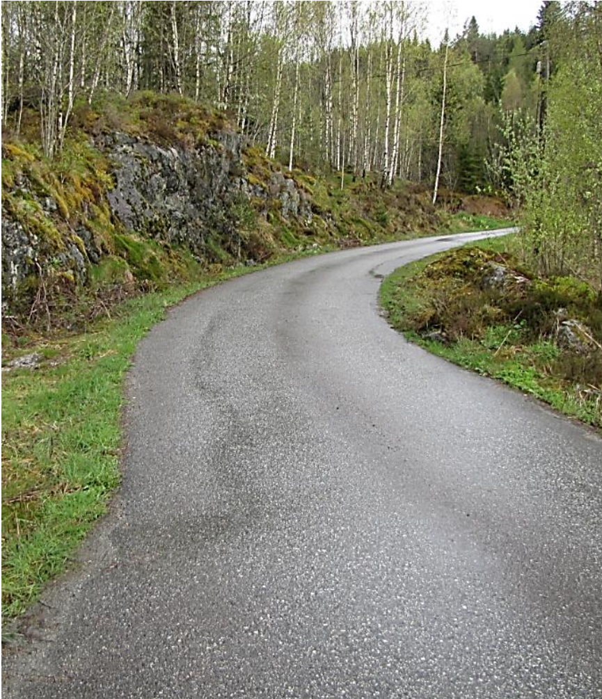
Figur 10 Vegen inn til anlegget.
