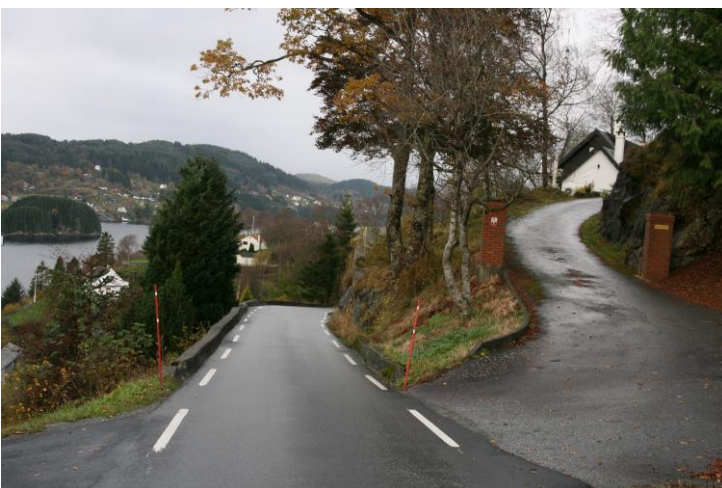
Figur 19: Foto av øvre del av Kvamsbrekka
