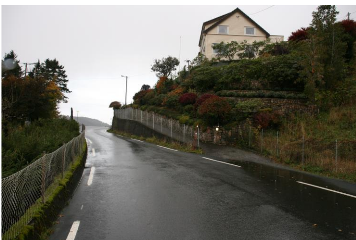
Figur 23: Foto av Fv 404 ved Skarsvegen 275
