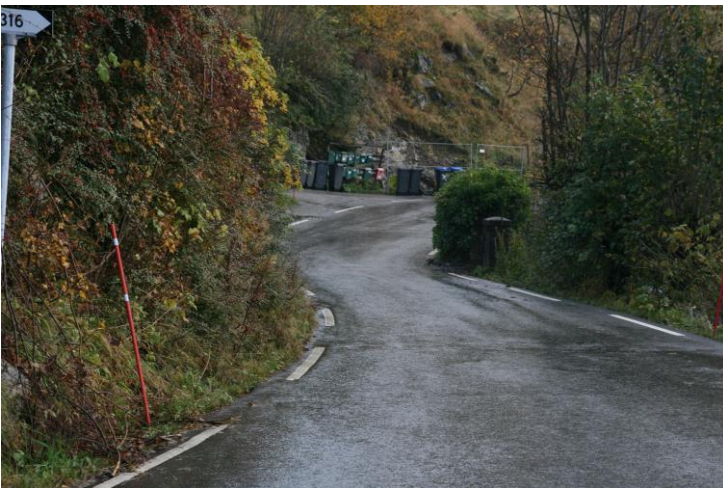
Figur 25: Foto av Fv 404 ved Skarsvegen 304/313
