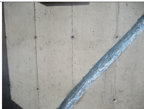
Bilde 3 - Utbedring av sprekken med elastisk fugemasse. Foto: Tommy Fauske
