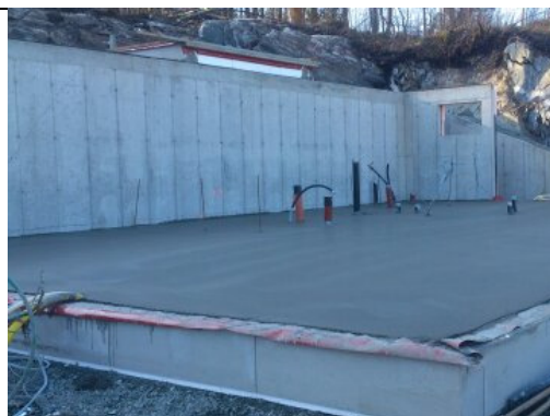
Bilde 1 - Grunnmuren sett fra 1. etg før avstivende innervegger er støpt. Foto: Tommy Fauske
