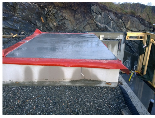
Bilde 4 - Grunnmur og plate ved inngangsparti etter at avstivende vegger innvendig er støpte. Foto: Tommy Fauske
