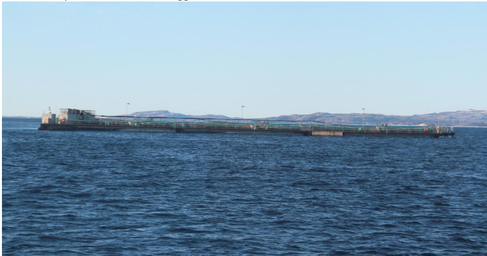
Lokalitet Ospeneset med stålanlegg
