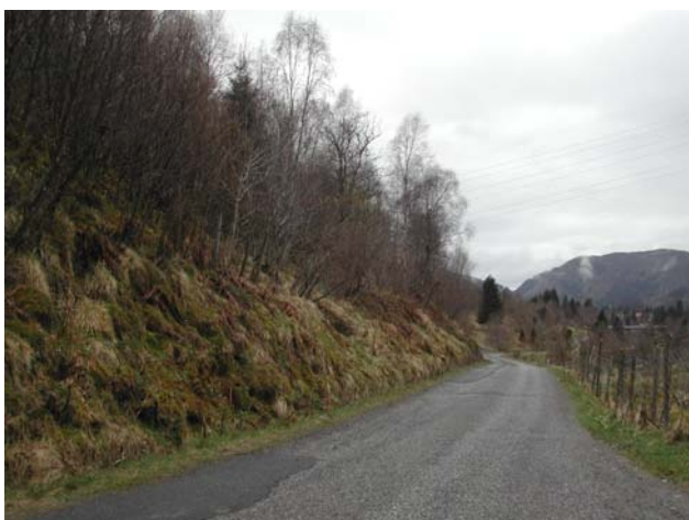
Lokalvegen sett nordover mot bru på Rv 566. Planområdet t.v.
