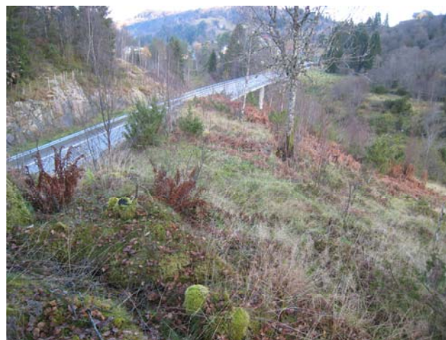
Rv 566 sett nordover, med bru over dalen.
