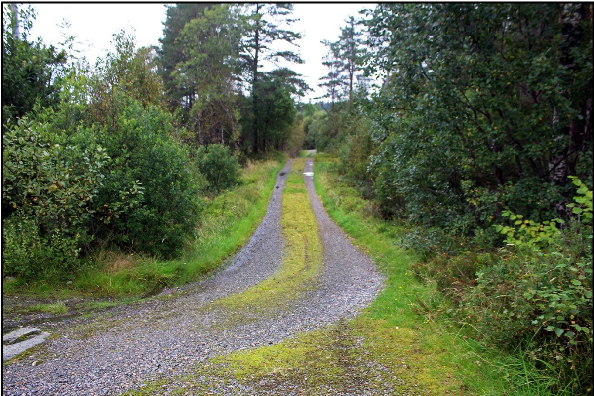
Strekningen før «oppgraderingen» sett mot nord. Foto: TE 7/9 2016.
