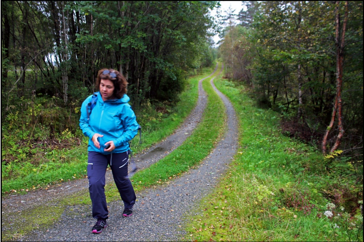
Strekningen før «oppgraderingen» sett mot sør. Bildet gir et inntrykk av hvordan vegbredden og toppdekket var for bare en måned siden. Foto: TE 7/9 2016.
