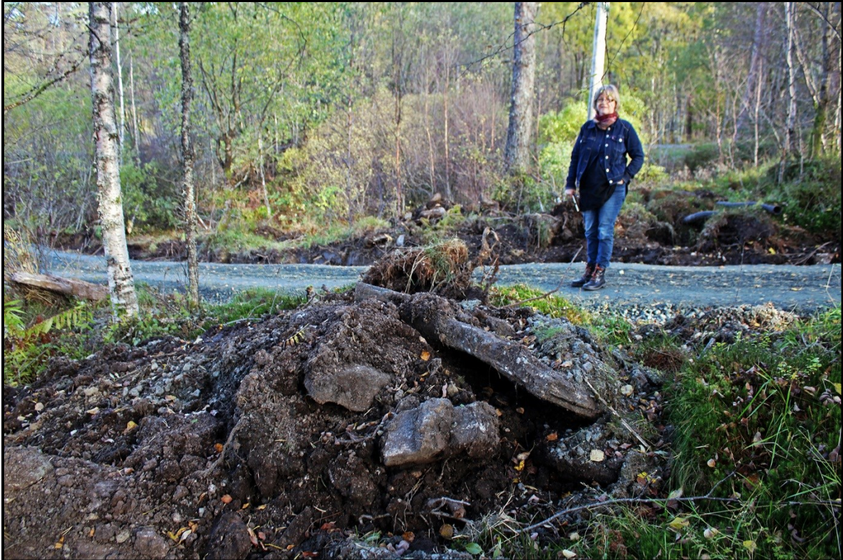
Eksempler på at vegkroppen – det vil si kantmuren – er fjernet og lagt på siden. Se både haugen foran, steinhella til venstre og haugene på andre siden. Foto: JA 15/10 2016.
