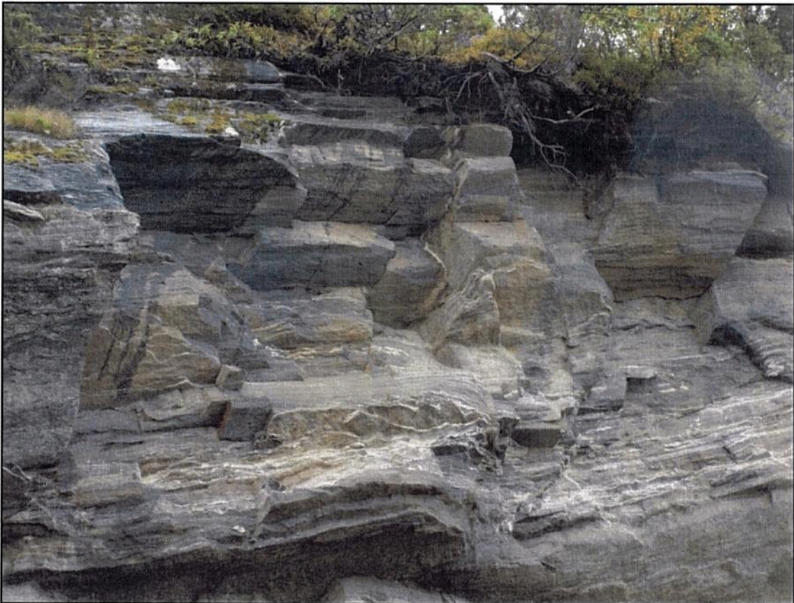
Fig 10. Det gjenstår løst materiale i skrenten.
