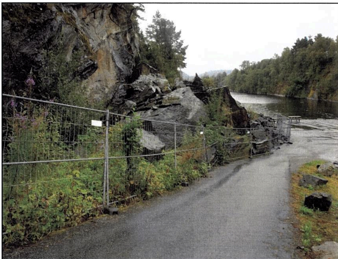
Fig 12. Akkumulasjon av det nedraste materialet.
