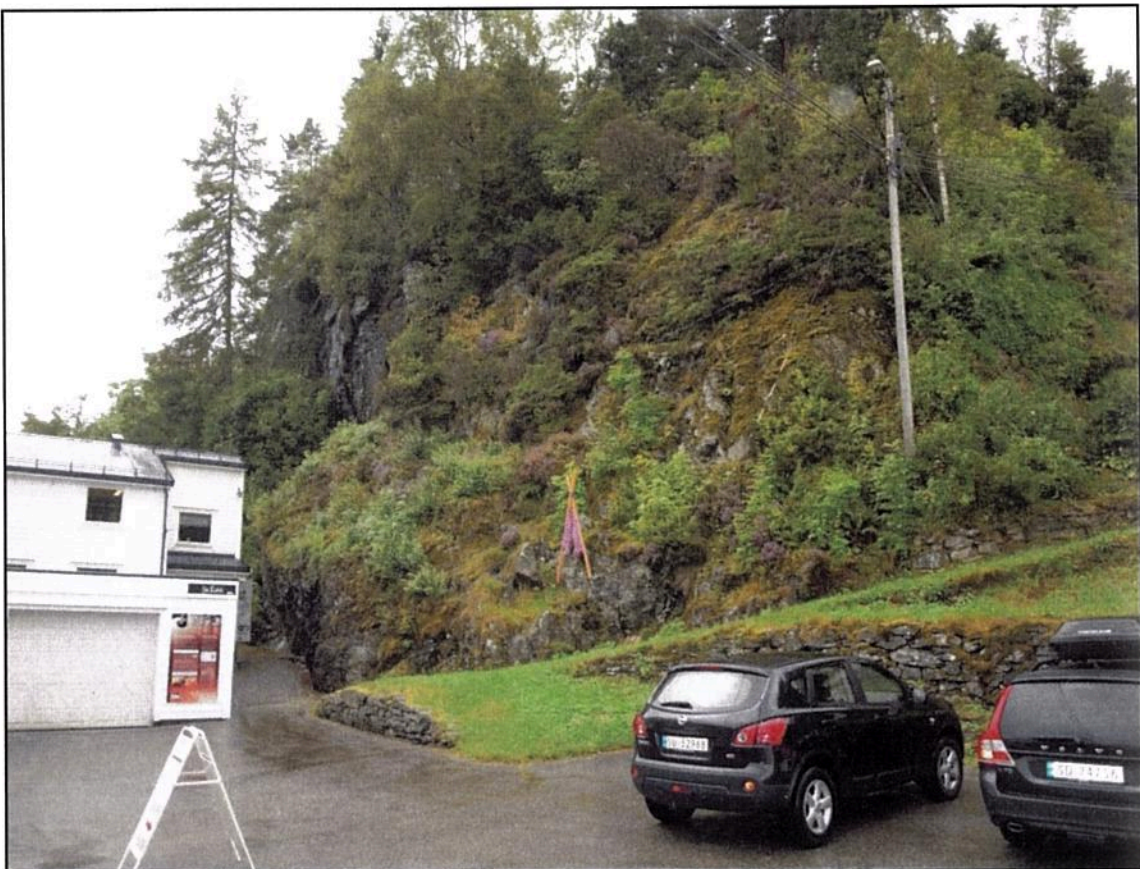
Fig 15. Øst for fabrikkbygning er det stabil overflate i skrenten.
