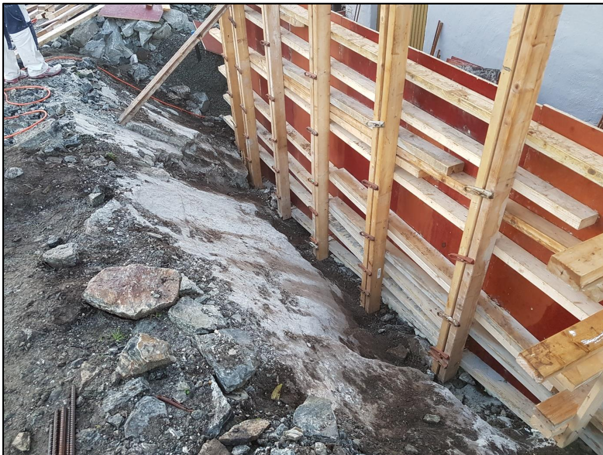
Figur 5 Bilde 18. oktober imed forskaling for ny trapp
