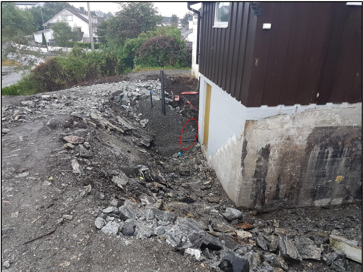
Figur 4 Bilde av utgravd område ved bolig etter at nytt drenssystem er etablert.
