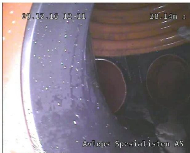
Foto: 28.14.jpg 28.14m, Vannivå 0%. Inspeksjon avsluttet i Kum S3 mini
