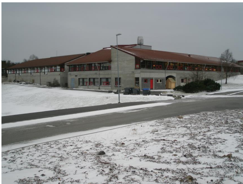
Bilde 1: Eksisterende del av Knarvik ungdomsskole
