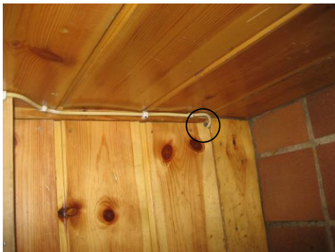
Bilde 3: Utett gjennomføring
