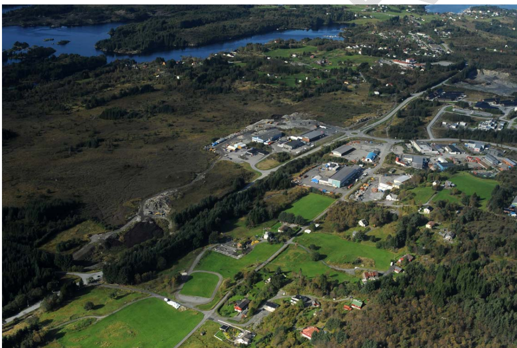
Figur 14: Skråfoto av Fv 57 Mongstadvegen fra kryss med Keilevegen til Mongstadkrysset. (Kjelde: Nordhordlandskart.no)
