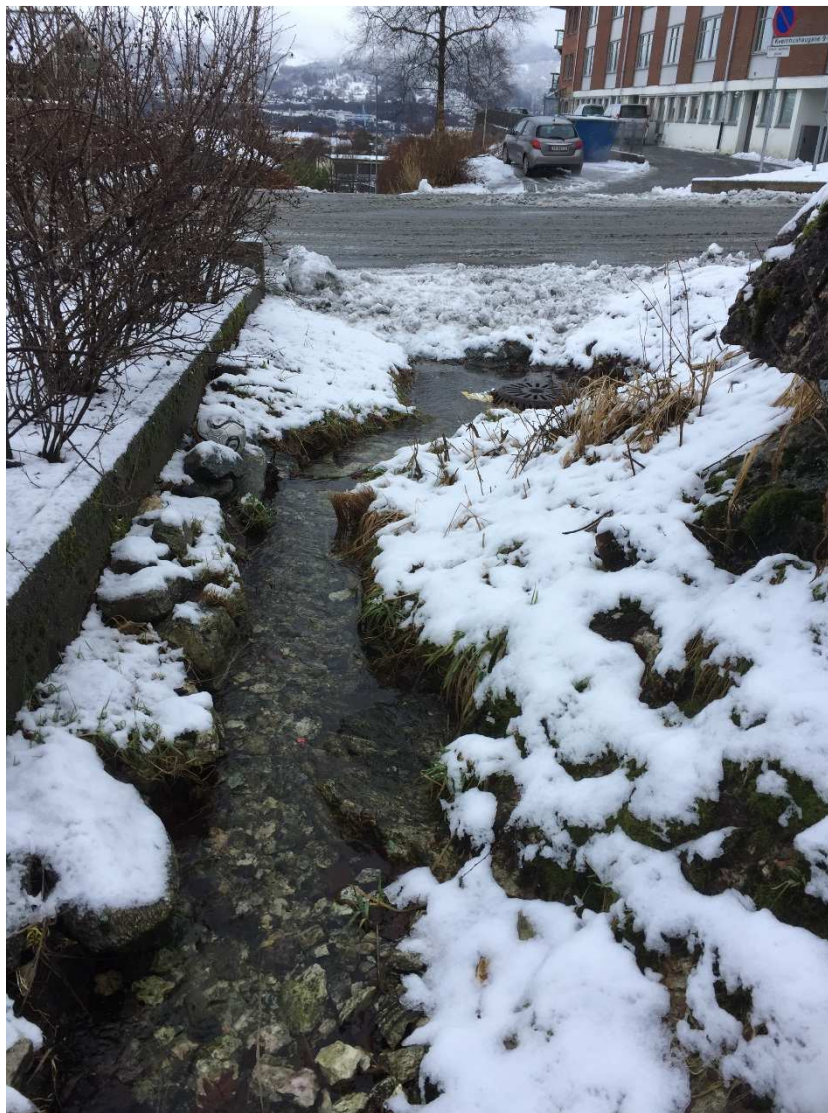
Bilde 1: Eksisterende sluk helt sør i skoletomt. Innløp til kommunal ledning.
