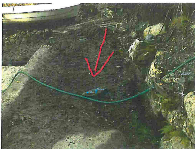
Punkt 4 er merket med stein og spray.
