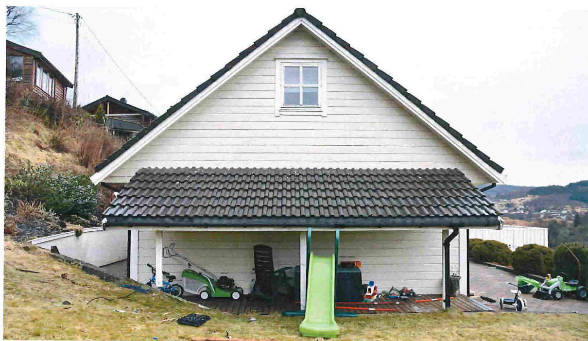
HOVEDHUSET , Gavf mot SYD
