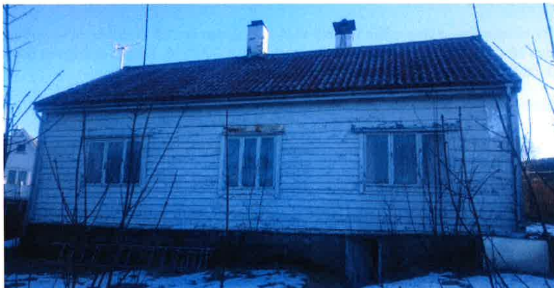
Eksisterende våningshus på bnr. 4, som skal rives
