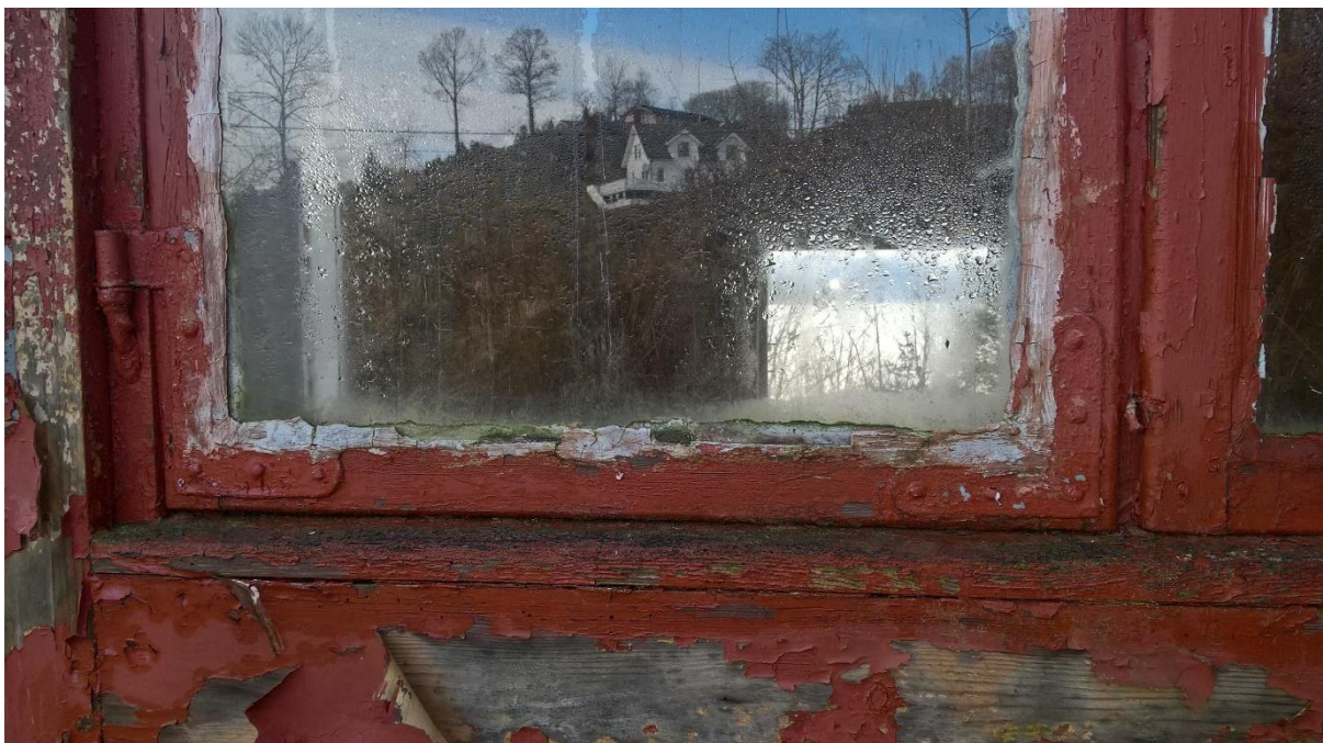
Bilde 2: Kittete ruter testet for asbest
